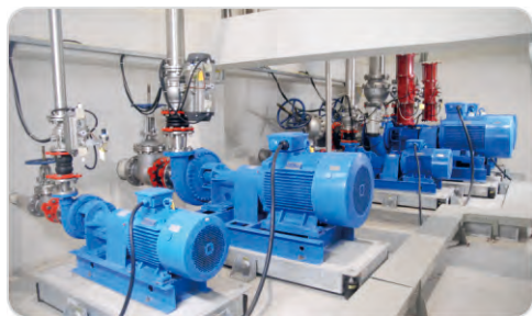
PUMP設備 (單顆出力最大為110KW)
