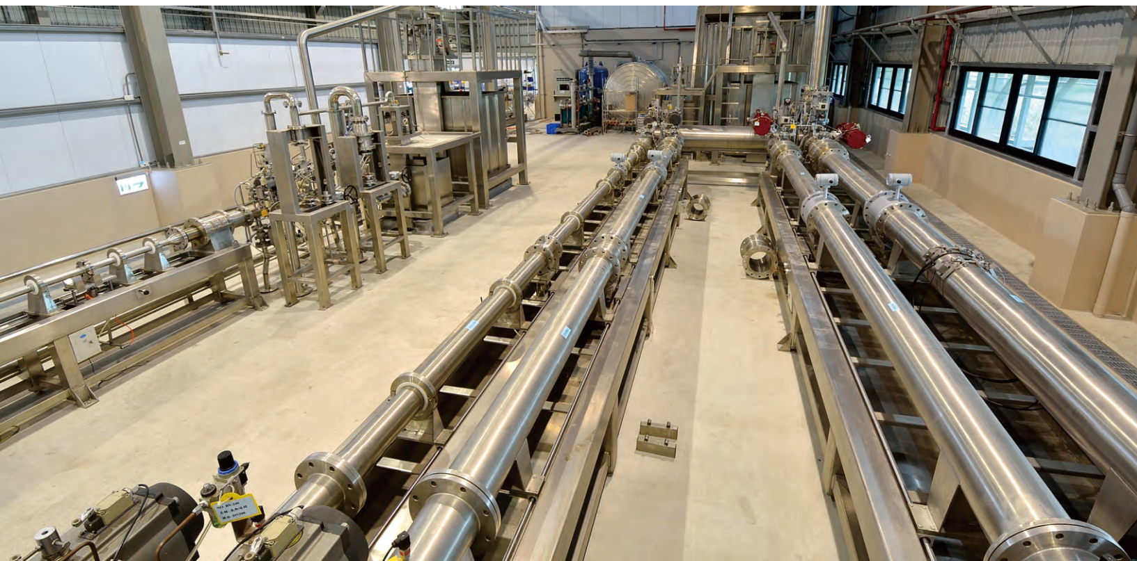
PUMP設備 (單顆出力最大為110KW)
