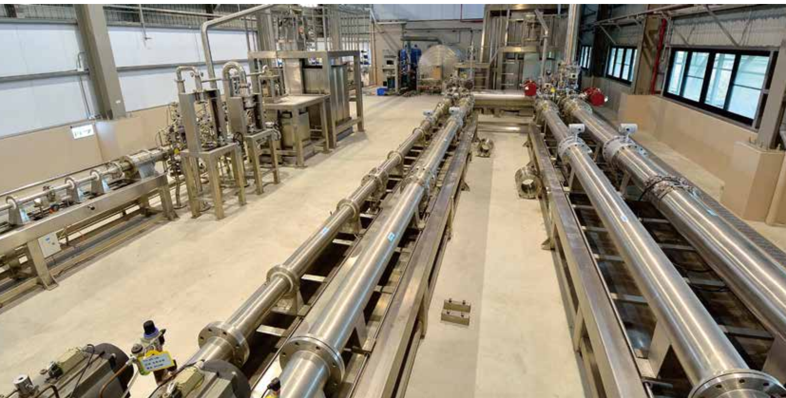
PUMP設備 (單顆出力最大為110KW)
