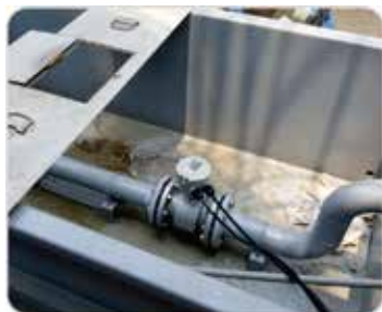
製藥業-廢水排放流量偵測
