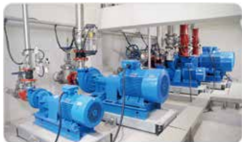
PUMP設備 (單顆出力最大為110KW)
